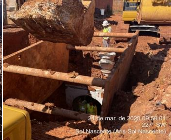
Execução da rede de drenagem
