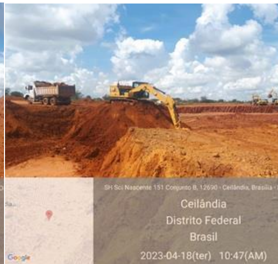
Escavação da bacia de retenção.
