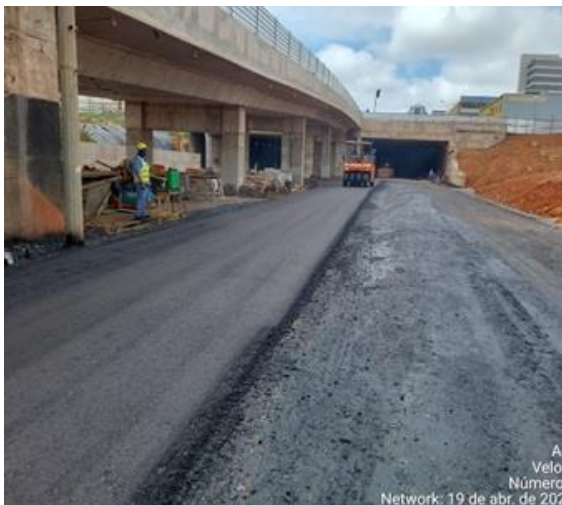
Execução de pavimento flexível (asfalto) na região do Túnel de Taguatinga.
