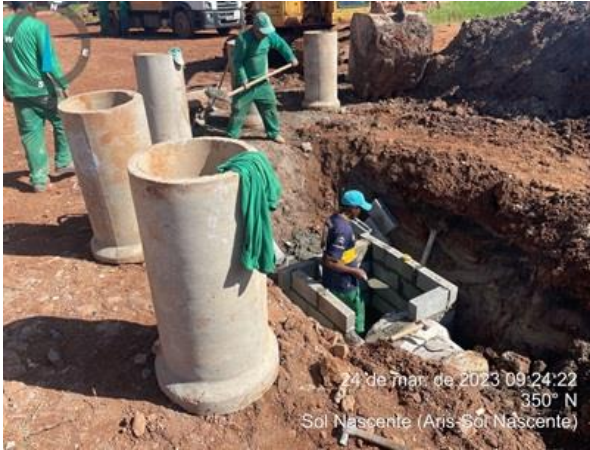
Execução da rede de drenagem.
