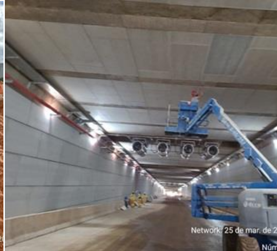
Finalização da instalação de forro em placas cimentícias.
