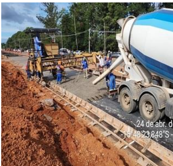
Execução de pavimento rígido.
