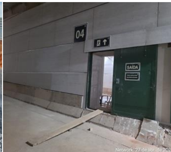
Instalação de portas corta-fogo nas saídas de emergência.
