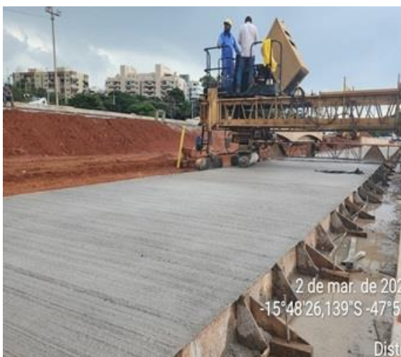
Execução de pavimento rígido (concreto).
