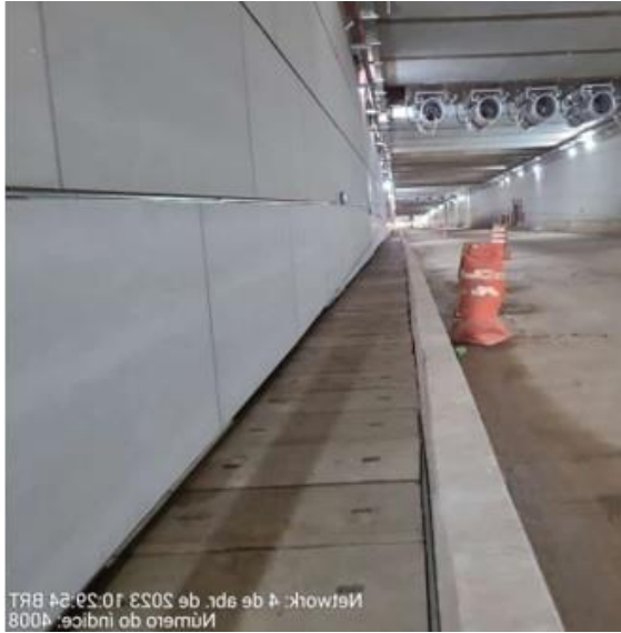
Instalação dos ventiladores do sistema de exaustão.
