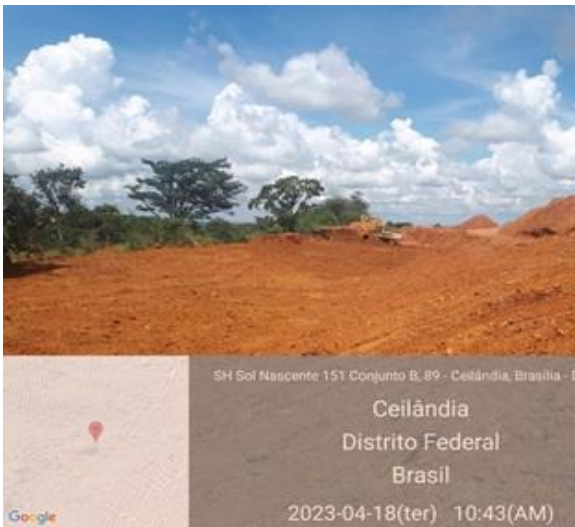
Escavação da bacia de retenção.
