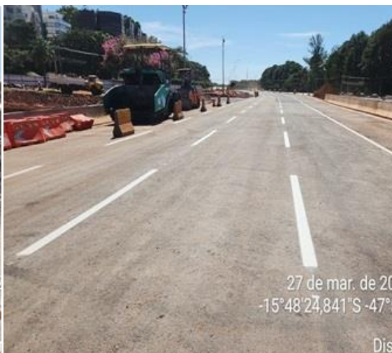
Execução de pavimento rígido (concreto) e pavimento flexível (asfalto); Sinalização horizontal.
