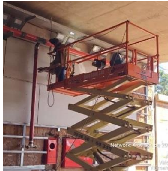
Montagem do sistema de combate a Incêndio.
