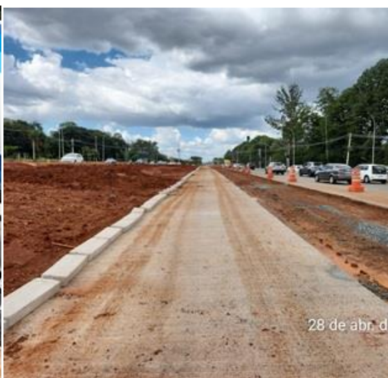
Assentamento de meios-fios.
