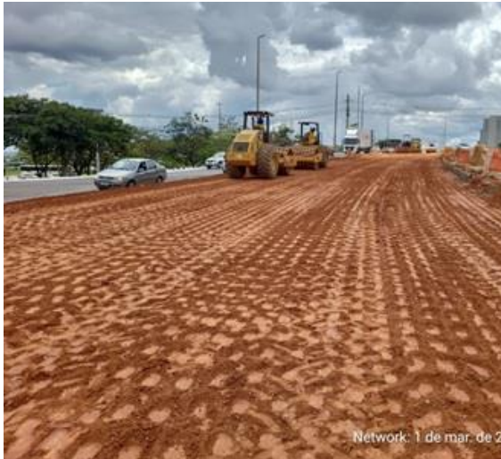
Terraplenagem na região do Boulevard.
