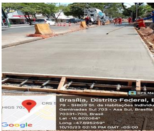
Concretagem do pavimento rígido.
