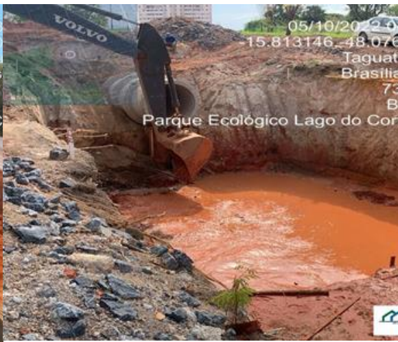
Escavação para a execução do "dissipador de lançamento" ao córrego.
