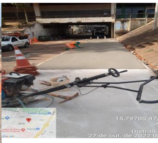
Execução de calçadas.
