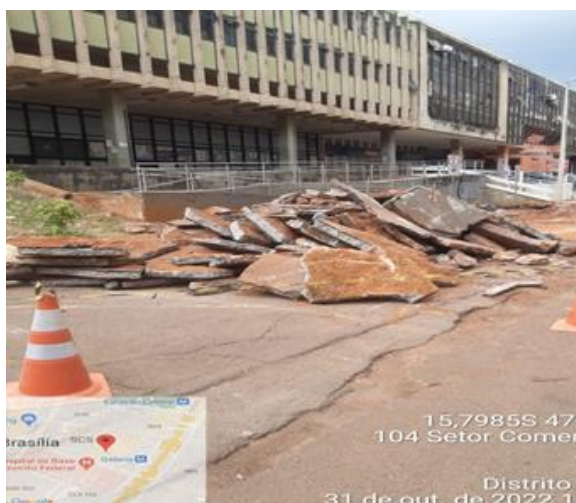
Demolição de calçadas.
