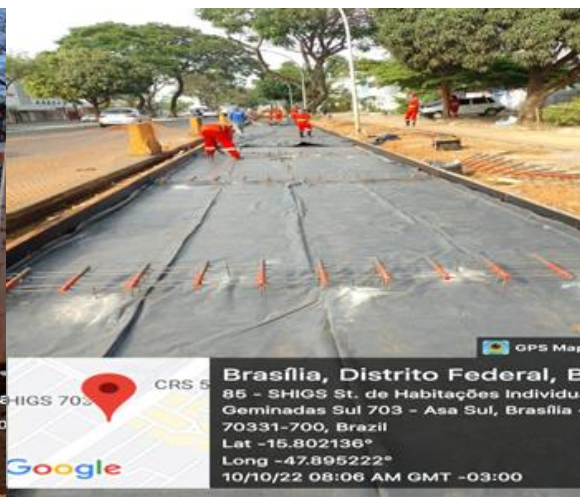
Preparação para execução do pavimento rígido.
