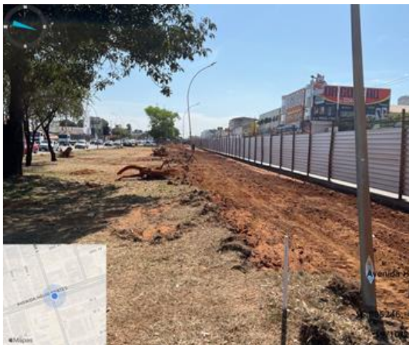
Supressão vegetal e demolição do pavimento existente para execução do "pavimento rígido".
