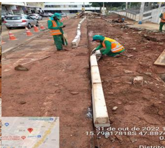
Assentamentos de meios-fios.
