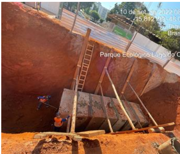
Execução de galeria de águas pluviais 1.80 x 1.80 na via entre a QI 10 e QI 14 do Setor de Indústria de Taguatinga.
