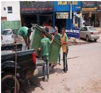
7 - Remoção de entulho
