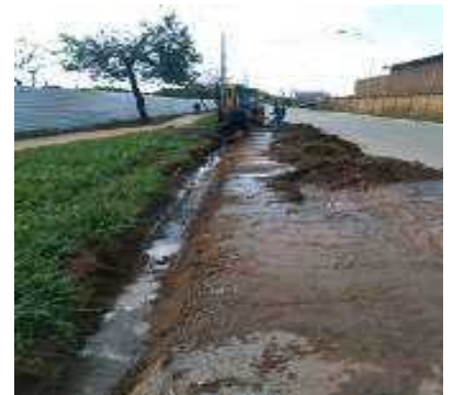
9 - Desobstrução de valas de contenção de águas pluviais
