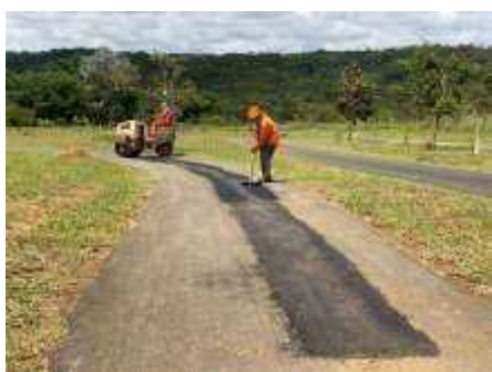
Figura 11. Recuperação de trechos do asfalto da coopervia.
