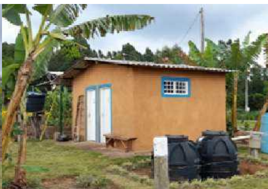
Figura 38. Pintura com tinta de terra e tratamento de efluentes domésticos no Circuito Saneamento Rural e SAN da AgroBrasília
