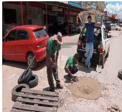
8 - Recuperação de bueiros
