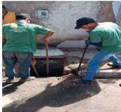
5 - Instalação de bocas de lobo
