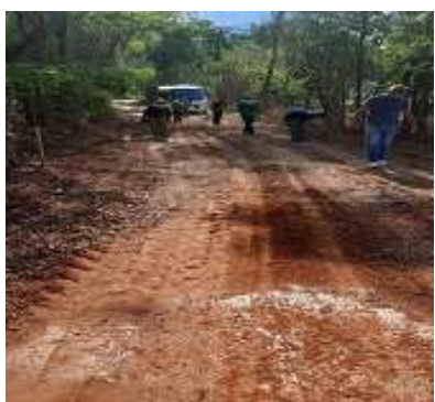
10 - Revitalização de estradas de chão
