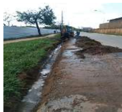
9 - Desobstrução de valas de contenção de águas pluviais
