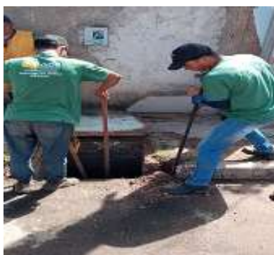
5 - Instalação de bocas de lobo
