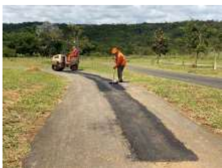
Figura 11. Recuperação de trechos do asfalto da coopervia.
