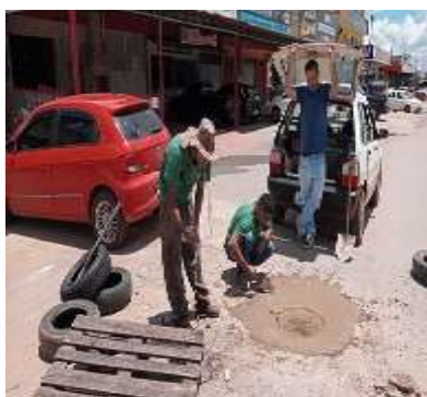
8 - Recuperação de bueiros
