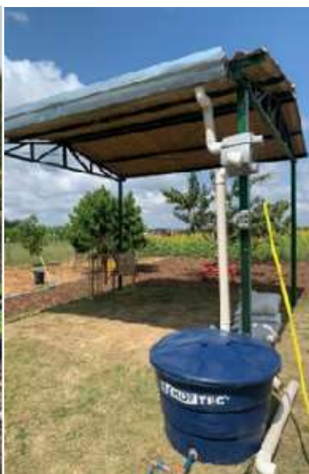
Figura 40. Sistema de captação de água da chuva no Circuito Saneamento Rural e SAN da AgroBrasília
